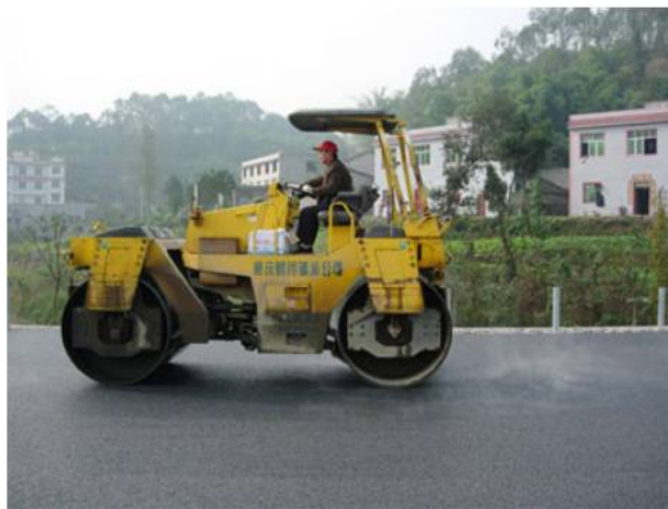
SW750N 重庆武合高速 SMA 施工现场
