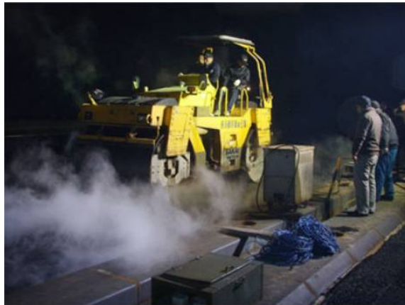
SW750N 无锡顺风立交桥钢桥部分 SMA 施工现场
