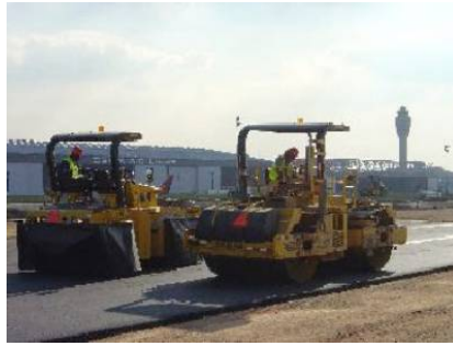
SW850 压路机美国佐治亚州、亚特兰大机场跑道工地上
