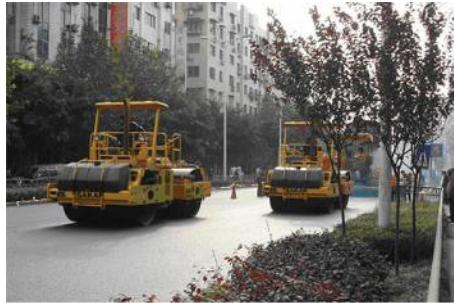
SW850 四川遂宁橡胶沥青 SMA 施工现场 (06年12月拍摄)
