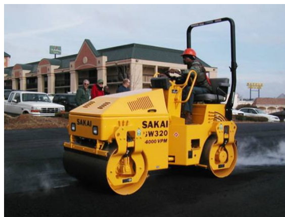
SW320 美国纽约州纽约市郊外某宾馆停车场的工地现场
