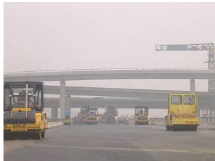
SW850 压路机在中国天津市高速公路建设工地上
