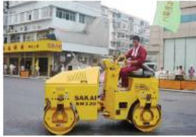
合肥建工市政建设施工现场
