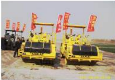
吉林交通集团建设工地
