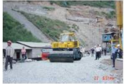
贵州落脚和发电站大坝工地
