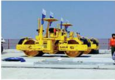
杭州湾跨海大桥施工
