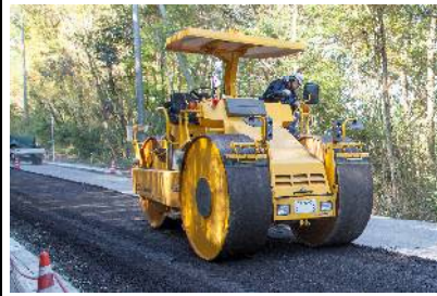
R2-2施工情况
