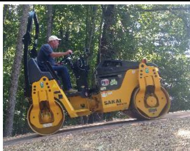
SW502-1施工情况
