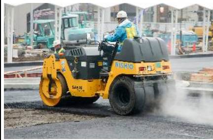
TW504施工情况
